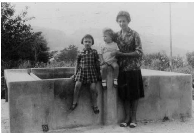
Lavatoio in cemento - n. 5
