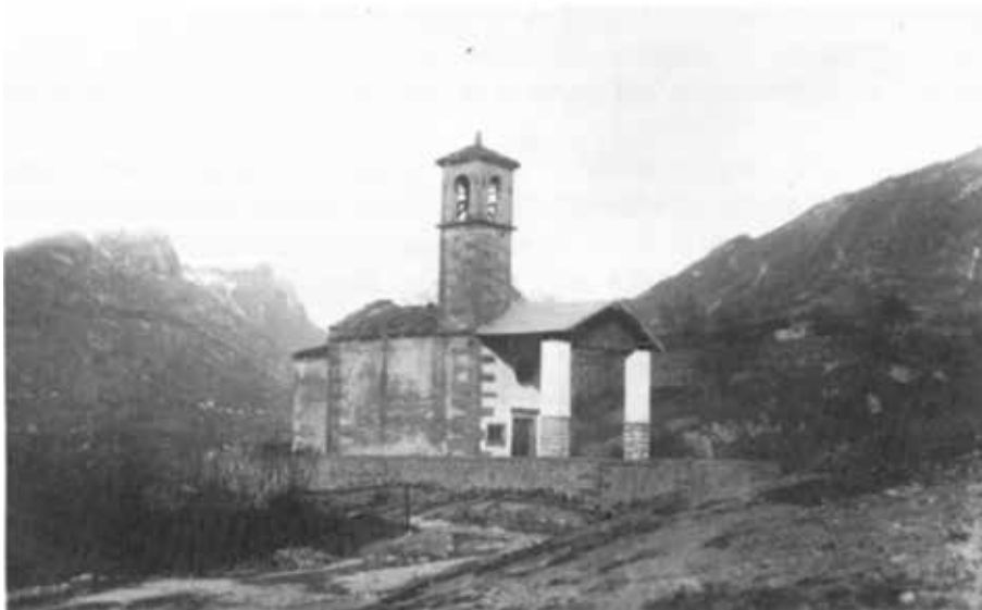
Una vecchia foto della chiesetta di S. Mauro, Grato e Giocondo. In particolare si nota il “pronaio” posticcio sulla facciata principale (ora inesistente).
