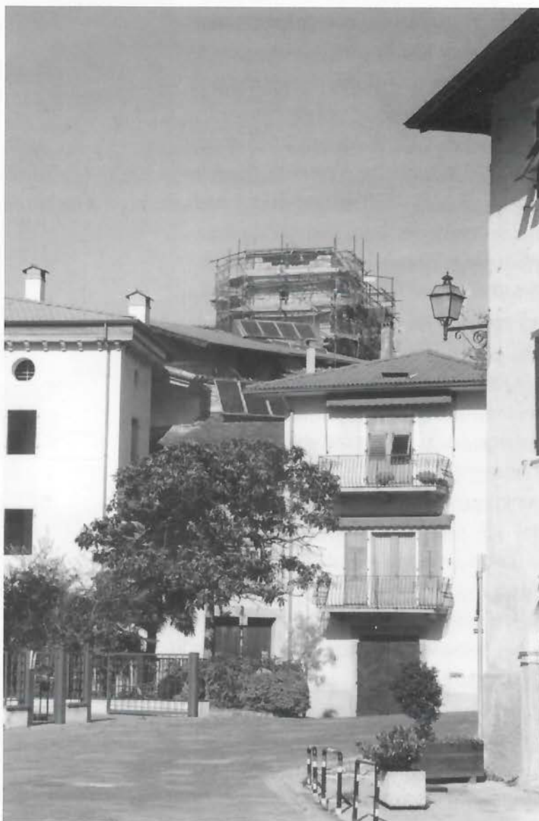
Lavori di restauro alla torre Guaita
